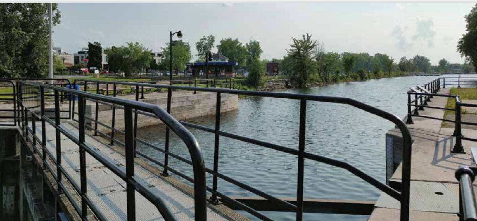
Passage piétonnier au-dessus des écluses de Lachine.
